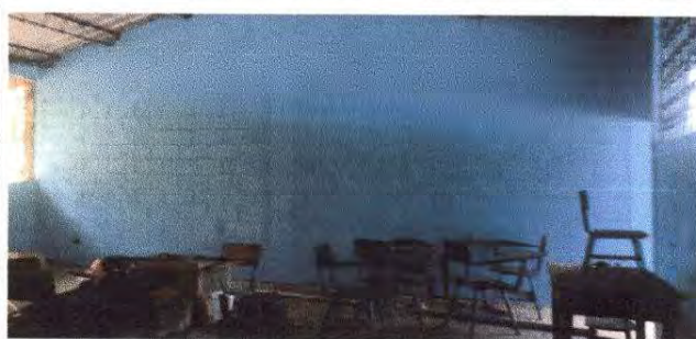
Foto 6: Pintura en muros interiores (aulas)
