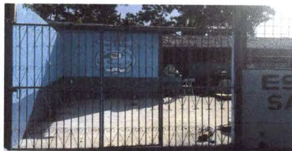
Foto 10: Mantenimiento a portón de metal (Ingreso principal al centro educativo)
