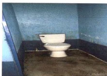
Foto 8: Sustitución de accesorios inodoro (contra llave, tubo de abasto, tanque) Sustitución de tapadera sanitaria.
