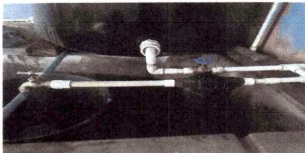
Foto 13: Sustrucción de accesorios depósito de agua
