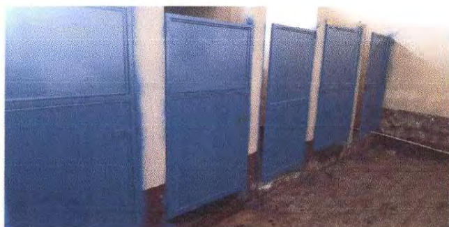
Foto 1: Mantenimiento a estructura (Lijado, cambio de tubo, cepillado, sujeciones, aplicaicones de pintura) en baños
