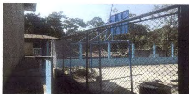
Foto 12: Reparación de tubo HG y malla galvanizada
