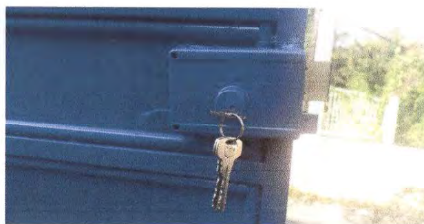
Foto 2: Sustitución de chapa (Dirección y un aula).
