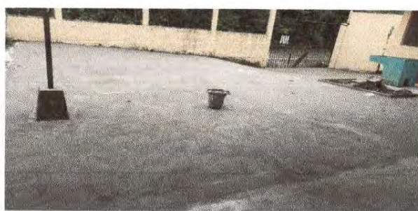
Foto 4: Sustitucion de piso torta de concreto en patio a la par de la cancha.
