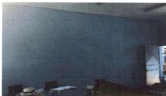
Foto 7: Pintura en muros interiores (aulas).
