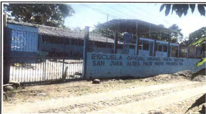
Foto 5: Pintura en muros exteriores en todo el centro educativo.
